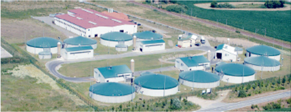
Abb.: Luftbildaufnahme einer Biogasanlage
